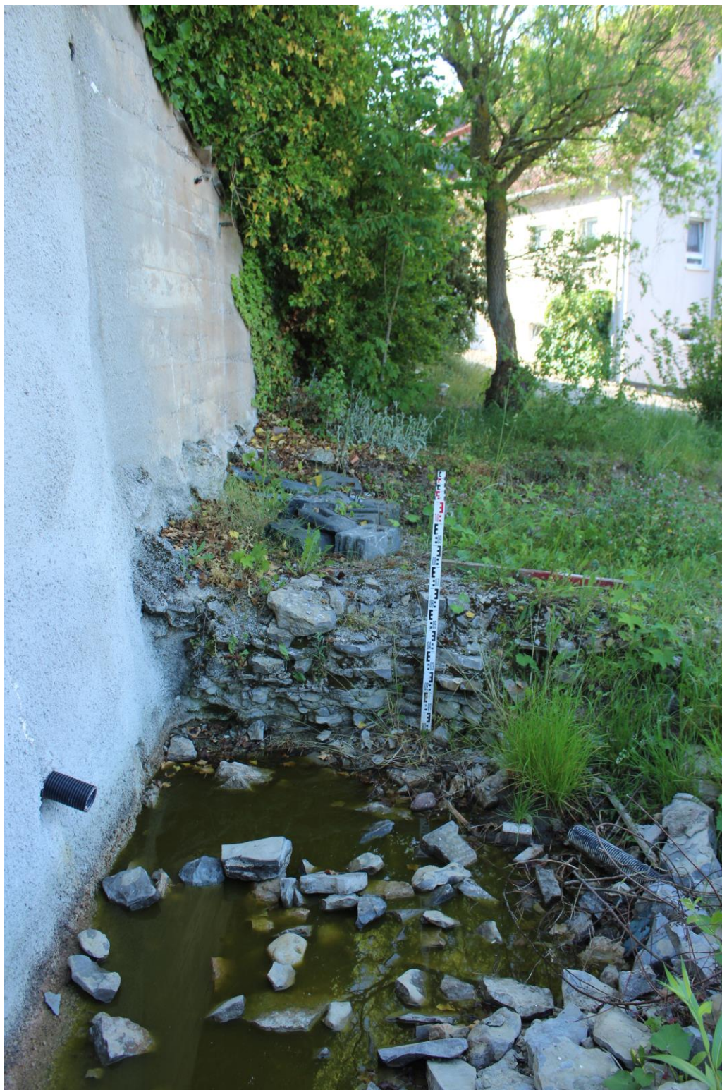
Anlage 11a Fotos von Böschung mit Schürfen am 18.06.2021, Beton-/Spritzbetonwand steht auf Fels (alte Schürfgrube)
