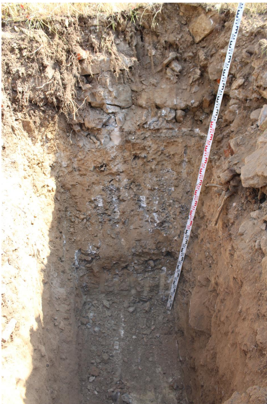
Anlage 11c Fotos von Böschung mit Schürfen am 18.06.2021, Mauern stehen auf Felszersatz/Fels (Schurf 2)
