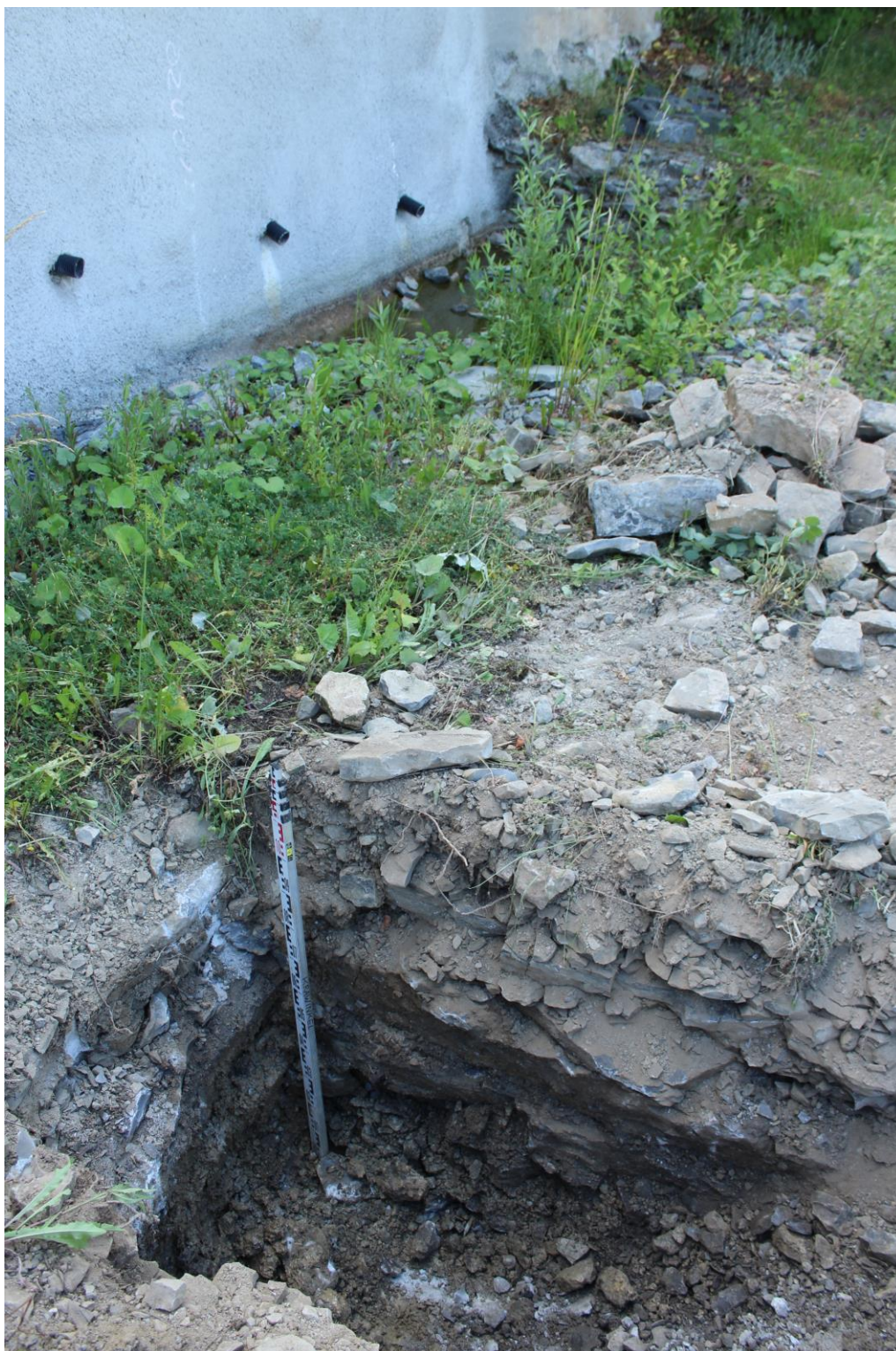
Anlage 11b Fotos von Böschung mit Schürfen am 18.06.2021, Spritzbetonwand steht auf Fels (Schurf 1)
