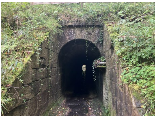
Abb. Aktuell bestehender Durchlass Berstlach
